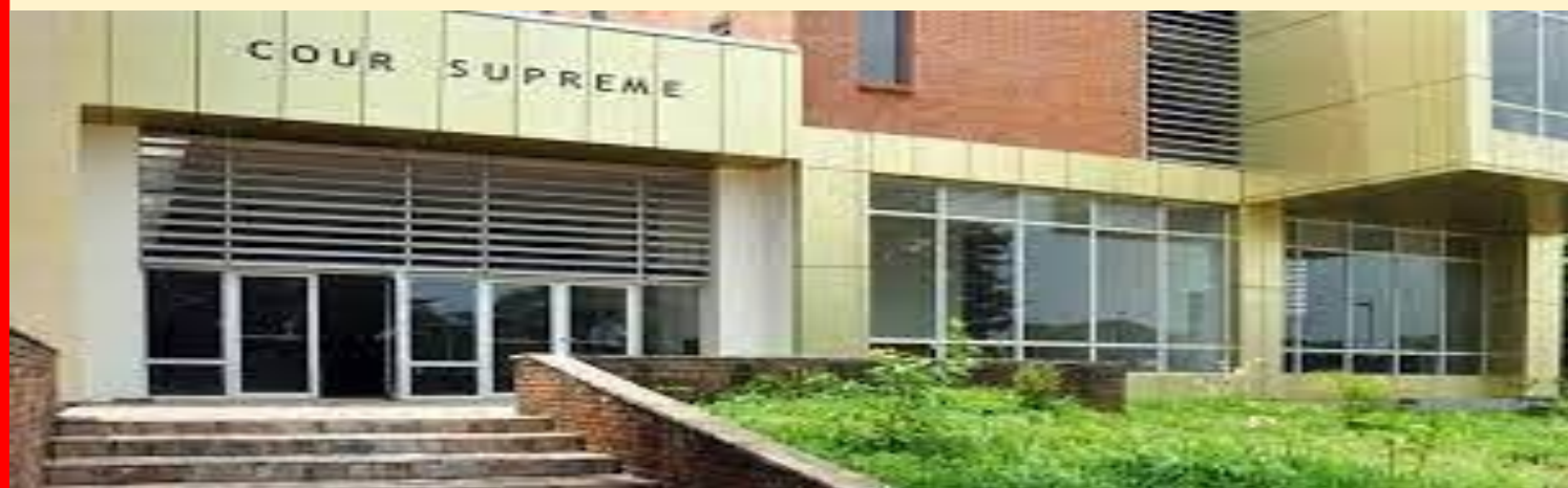
Vue partielle du building abritant la Cour Suprême du Burundi
